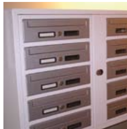
Värmepumpar och postfack är exempel på stomljudsalstrande installationer.
