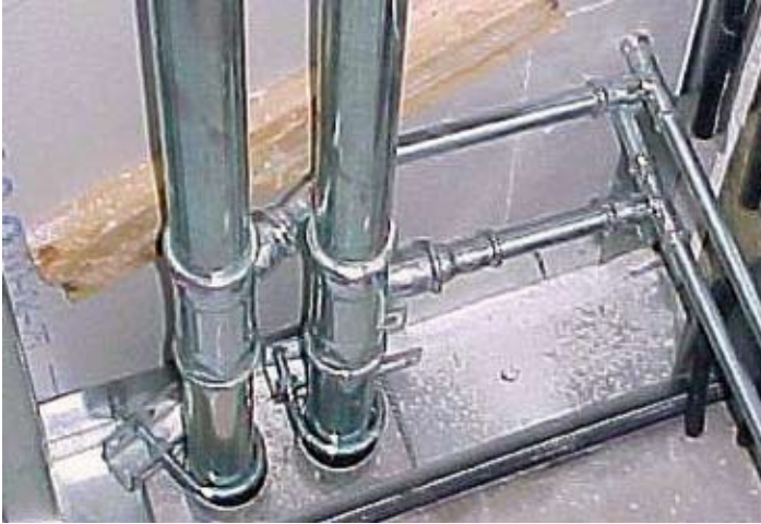
Kortling ger stomljuskontakt rör – vägg.
