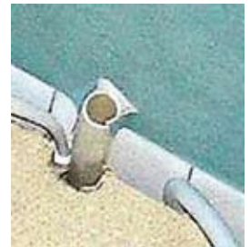
"Extra" kablar kläms mellan flytande golv och vägg.
